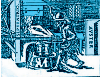
চিত্র 5.15 একজন কামার, উত্তর দক্ষিণ অভিমুখে রাখা একটি লোহিত তপ্ত লোহার দণ্ডকে হাতুড়ি দিয়ে আঘাত করে স্থায়ী চুম্বকে রূপান্তর করছে। 1600 খ্রি: প্রকাশিত ইংল্যান্ডের রাণী এলিজাবেথের পারিবারিক চিকিৎসক উইলিয়াম গিলবার্টের লেখা 'দি ম্যাগনেটে' (De Magnete) পুস্তকের একটি চিত্র থেকে এটি পুনরায় সৃষ্ট।
